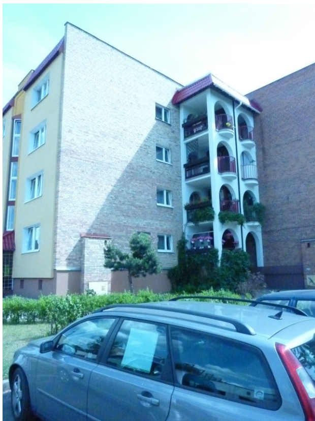
Fot. 1 Elewacja szczytowa zachodnia
