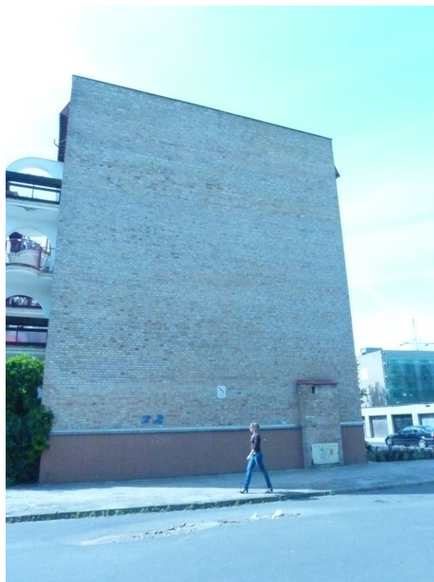
Fot. 2 Elewacja szczytowa - wschodnia
