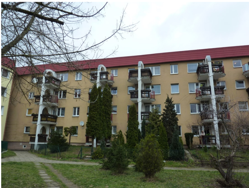
Fot. 3 Elewacja południowa
